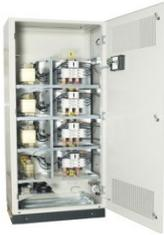
La batterie de condensateur Alpimatic type SAH est une batterie automatique à commutation par contacteurs électromécaniques. La MS27540.189 est composée de racks ALPIMATIC avec selfs anti-harmoniques type R7. L'ensemble est piloté par le régulateur varométrique ALPTEC.
